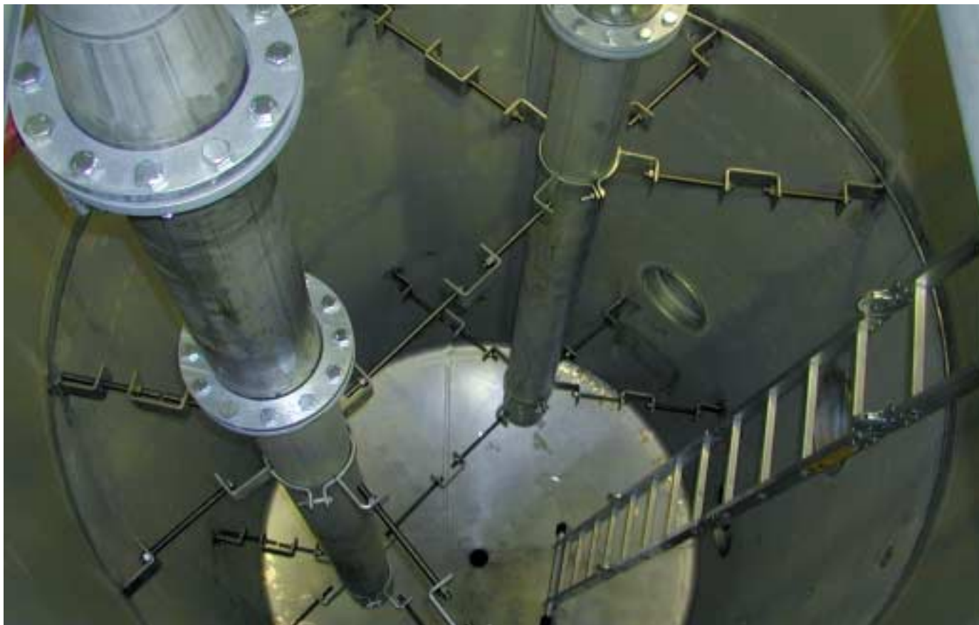
Lappeenrannan lauhdutusallaskoelaitteiston allas puhallusputkineen. Tutkimuslaitteisto sijaitsee Lappeenrannan teknillisen yliopiston kampuksella tutkimushallissa joka elää jatkuvasti muuttuvien koevaatimusten myötä. Todettakoon että tunnetuin laitteisto, PACTEL, palvelee edelleen osana kokeita, joiden suunnittelu ja toteutus on osa arvokasta suomalaista kokeellista tutkimusta. (Kuva LTY/YTY.)
