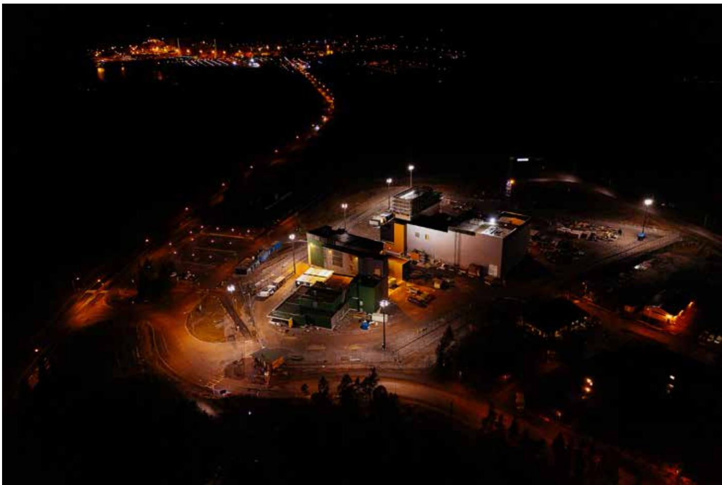
Kapselointilaitoksen (kuvassa takimmainen rakennus) rakennustyöt käynnistyivät kesällä 2019 ja rakennus nousi harjakorkeuteen joulukuussa 2021 (kuva: Posiva Oy).
