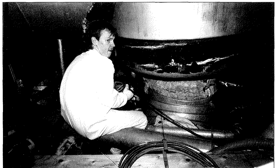
Höyrytimen suojataskun tukkeutuneen puhallusputken avausta.
