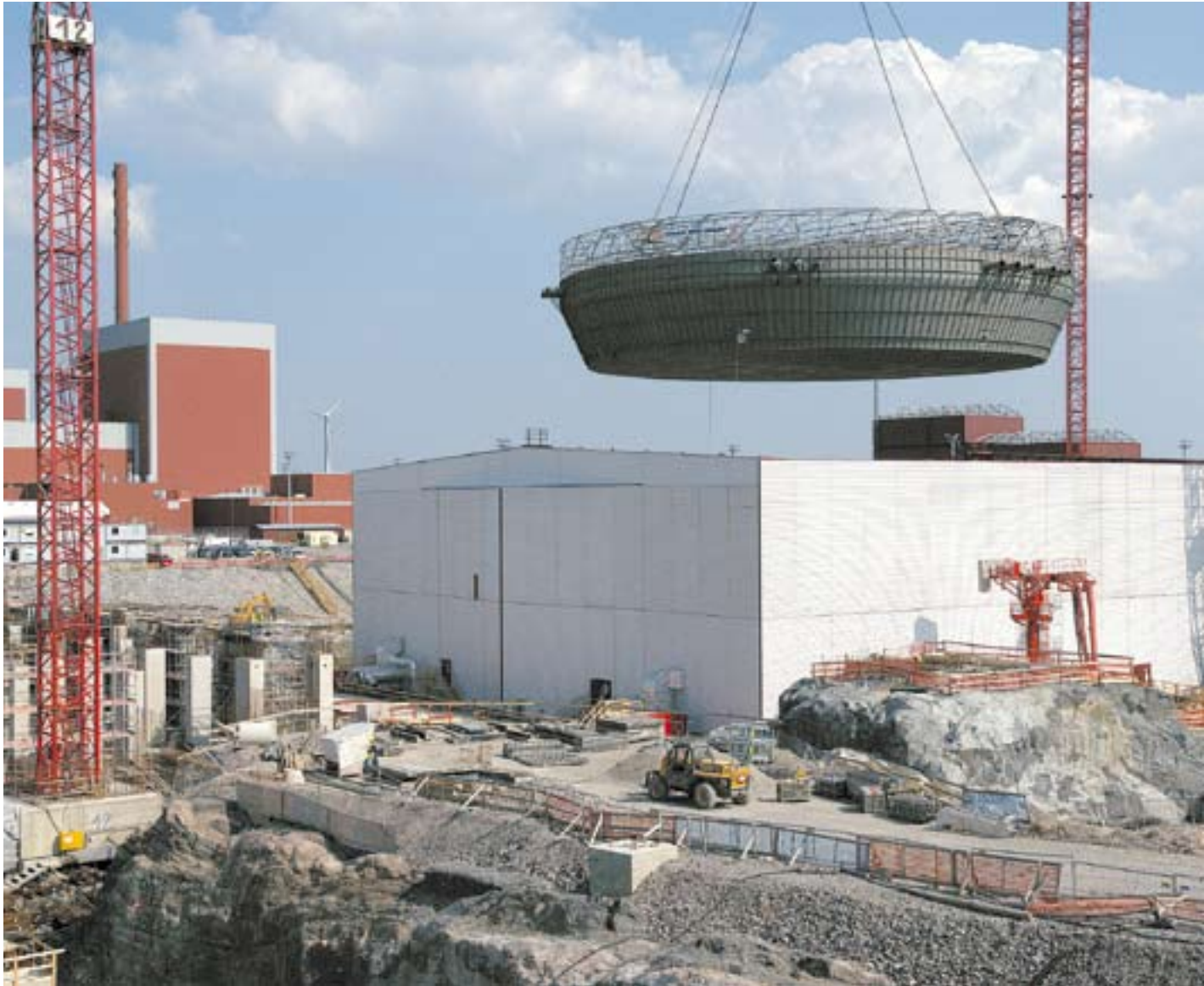
Uuden ydinvoimalan rakennustyöt etenevät. Näyttääkö Suomi voimalahankkeellaan suuntaa muulle Euroopalle? (Kuvat: TVO)
