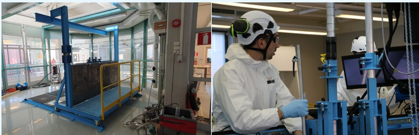
Kuva 2. Purkusilta asennettuna ja käyttövalmiina sekä käytössä purkutöiden aikana (kuva: VTT).
