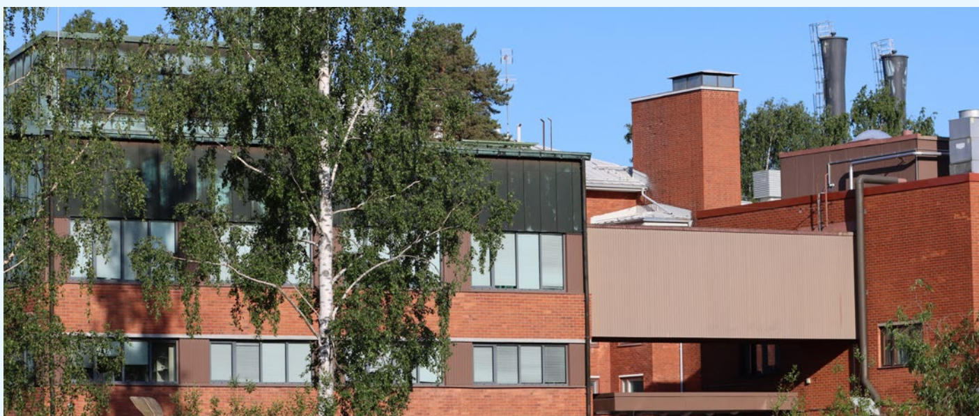
Kuva 5. FiR 1 -reaktorirakennus Otaniemen kampuksella ennen purkuvaiheen alkua. Yksi reaktorin kolmesta pienestä jäähdytystornista näkyy aivan kuvan oikeassa reunassa viereisellä katolla (kuva: VTT).
