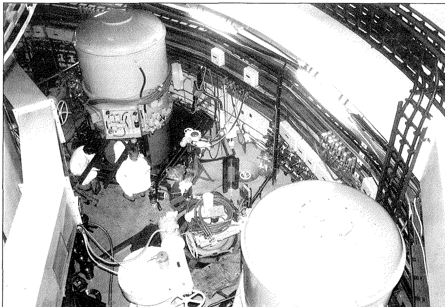
Loviisan pääkiertopumput on valmistettu Ahlströmin Karhulan tehtailla ja moottori on Strömbergin.
