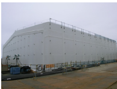
ALPS-rakennus lähes valmiina maaliskuussa 2013. Kuva: TEPCO.
