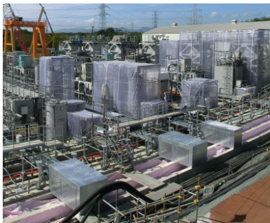
ALPS-laitteiston asennustyö syyskuussa 2012. Kuva: TEPCO.
