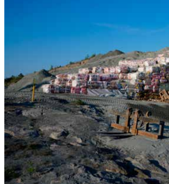
Maaperäloppusijoitustila Ringhalsissa käytön aikana ja sen päätyttyä.
