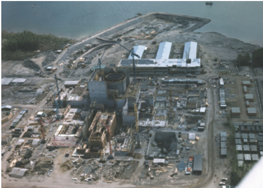
Olkiluoto 1:n rakennustyömaa vuonna 1975 puolitoista vuotta rakentamisen alkamisesta.
