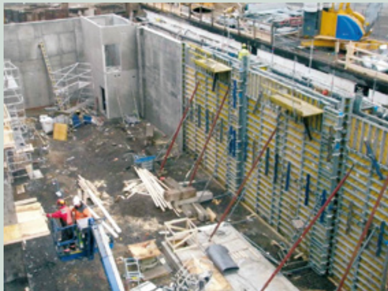
Rakenteilla oleva uusi koehallin laajennusosa, johon uusi syklotroni ja isotooppien on-line-erotinlaitteisto IGISOL ja JYFLTRAP tullaan sijoittamaan.
