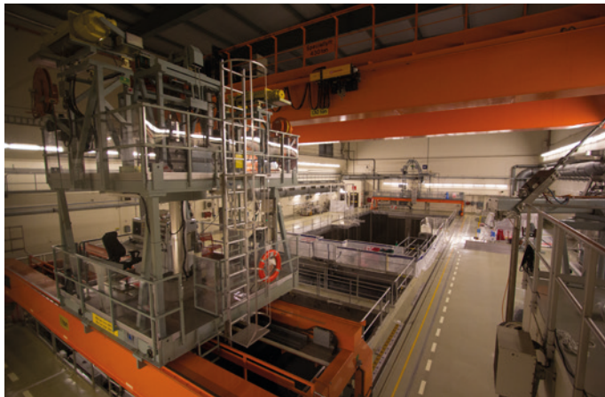
Barsebäckin reaktorihalli: vasemmalla näkyy polttoaineen latauslaite.
