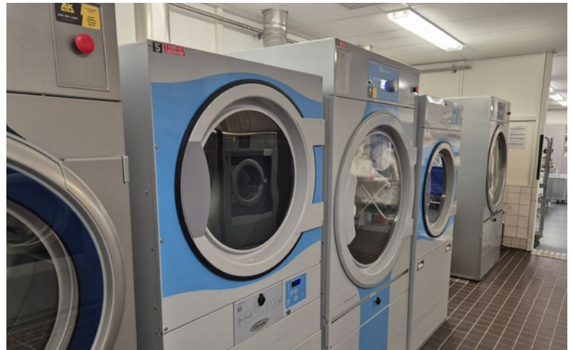
Kuivausrumpujen poistoilma on ohjattu suoraan valvonta-alueen ilmanvaihtojärjestelmään.
