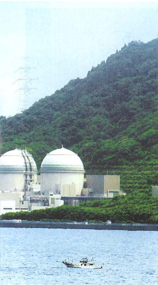
Näkymä Takahaman laitosalueelle Wakasa-lahdelta kuvattuna. Vasemmalla ovat 826 MWe tehoiset laitosyksiköt 1 ja 2 ja oikealla 870 MWe tehoiset yksiköt 3 ja 4. (Kuva: KEPCO)
