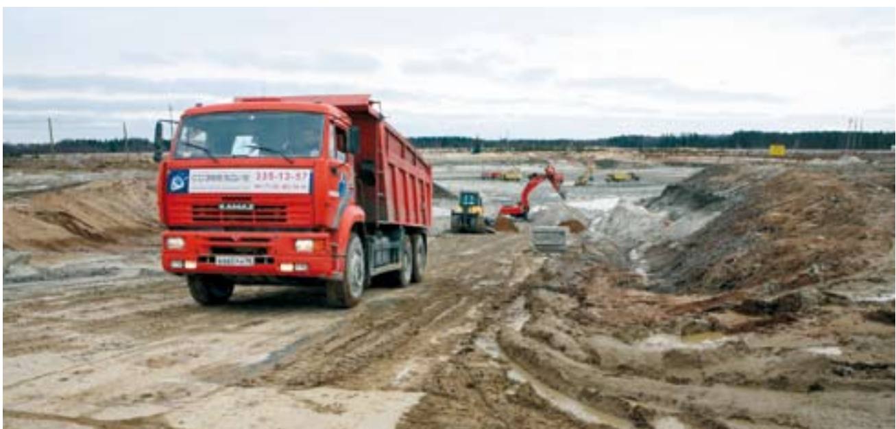
Maanrakennustyöt käynnissä LAES-2:n alueella Sosnovy Borissa.
