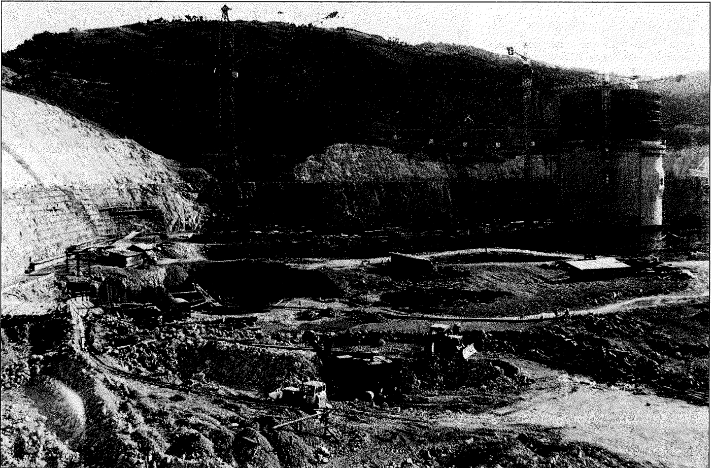
Kuva 8. Yleisnäkymä Qinshanin ydinvoimalaitostyömaalta.
