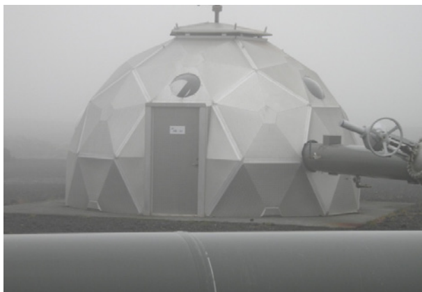
Uusinta iglu-muotia, vai mitä? Ei sentään, kyseessä on rakennelma reikiä varten, joista johdetaan kuuma vesi ja höyry voimalaitokselle. Kuva: Tomas Lehtimäki.
