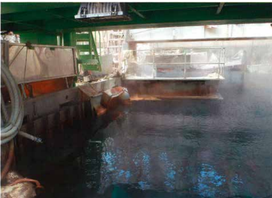
Kuva 5. Fukushima Dai-ichin nelösyksikön polttoaineallas on viimeisenä ilman jäähdytyskiertoa räjähdysvaurioitettua putkistoa (kuva: Tepco 29.6.2011).
