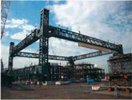
Kuva 4. Fukushima Dai-ichin ykkösyksikön säätösuojan tukirakenteita koeasennettuna Onahaman satamassa 24.6.2011 (kuva: Tepco).
