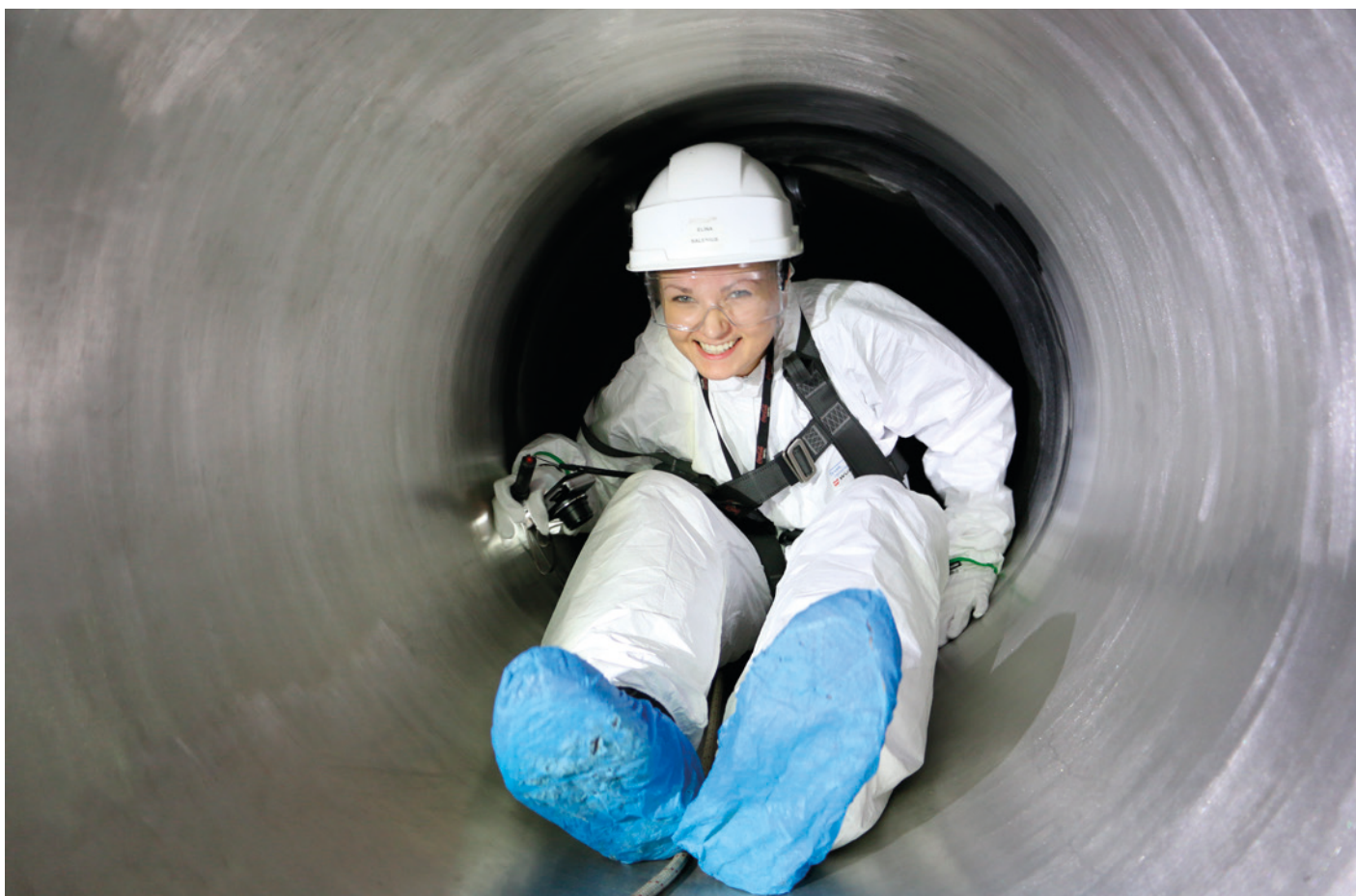
Primääripiirin tarkastus OL3:n Nuclear Circuit Cleaning (NCC) -käyttöönottokokeen jälkeen. NCC:ssä useita laitoksen prosessi- ja automaatiojärjestelmiä ajetaan yhtä aikaa.
