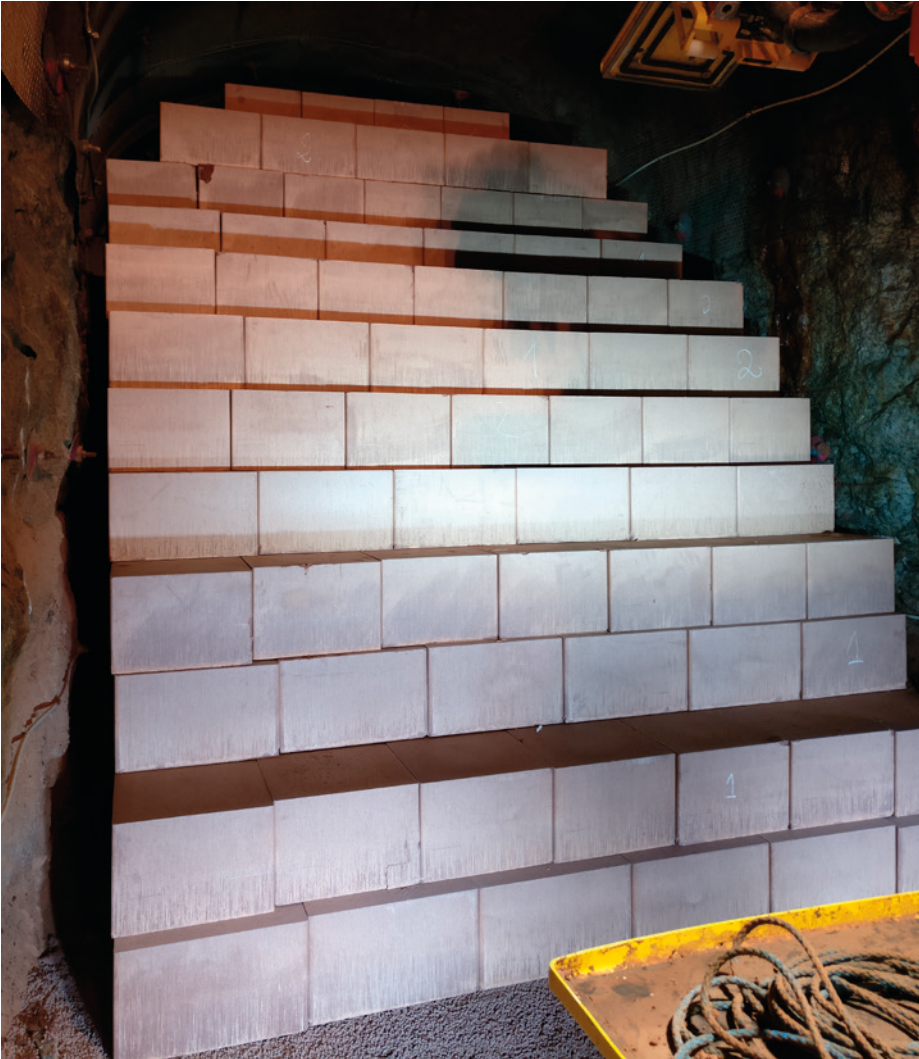
Asennetut täyttölohkot (kuva: Posiva Oy/Risto-Matti Meriniemi).
