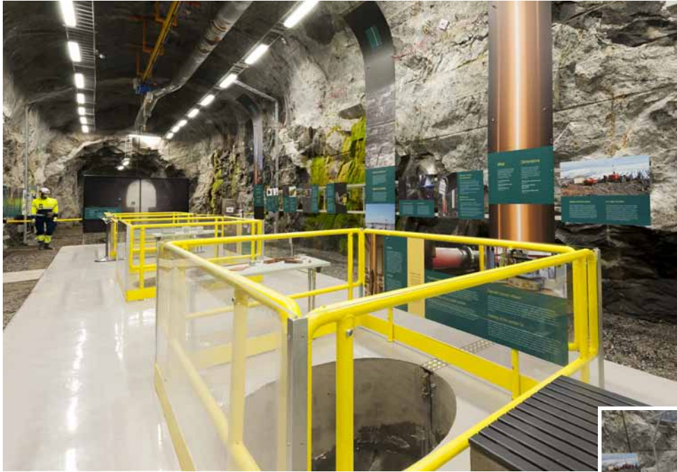
Loppusijoitusreiät ovat yli seitsemän ja puoli metriä metriä syviä
