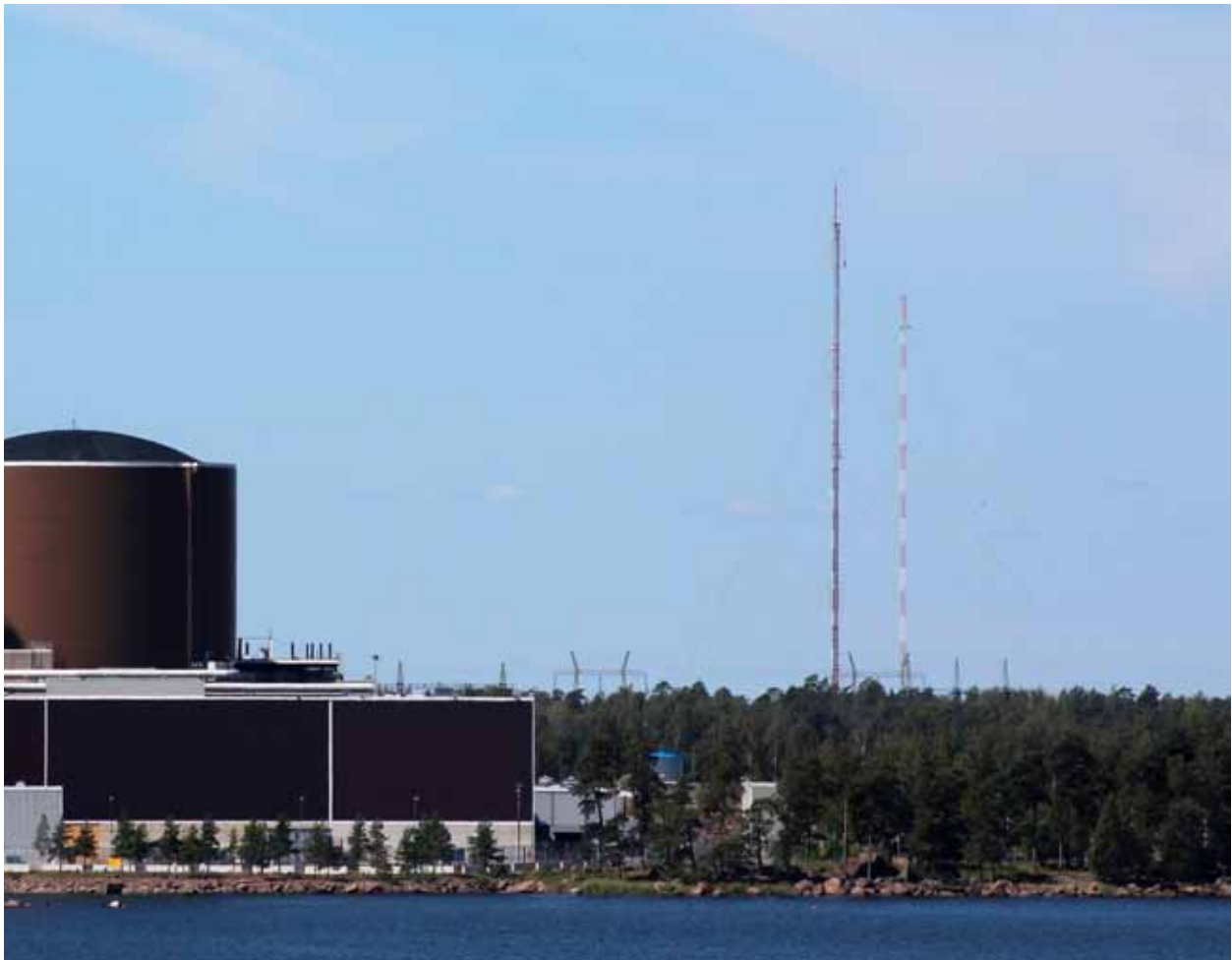
Loviisan voimalaitos ja kaksi säämastoa, Kasaberget heinäkuussa 2014. Kuva: Klaus Sjöblom.
