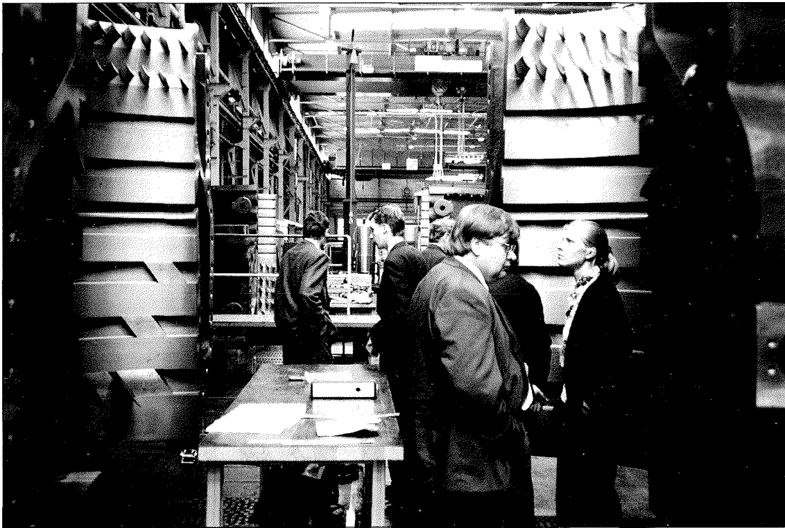
Tarkkaa tutustumista kohteisiin — tässä kaasuturpiiniin.
