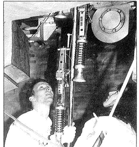
Loviisa 1:n paineastian hehkutus kesällä 1996 mahdollisti laitoksen käyttööden pidentämisen.
