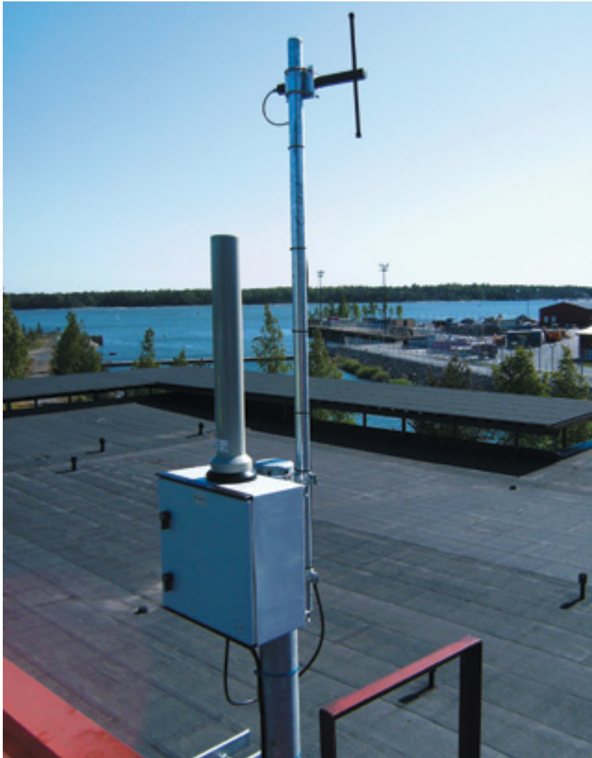
Olkiluodon lähialueen ulkoisen säteilyn mittausasema lähettää reaaliajassa langattoman viestin anturilukemista keskusjärjestelmään.
