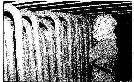
Tulistimien putkien elinikää voidaan moninkertaistaa käyttämällä TE-6, TE-7 ja TE-22 pinnoitteita. TE-6 ja TE-7 pinnoitteet ovat Telatekin patentoimia.
