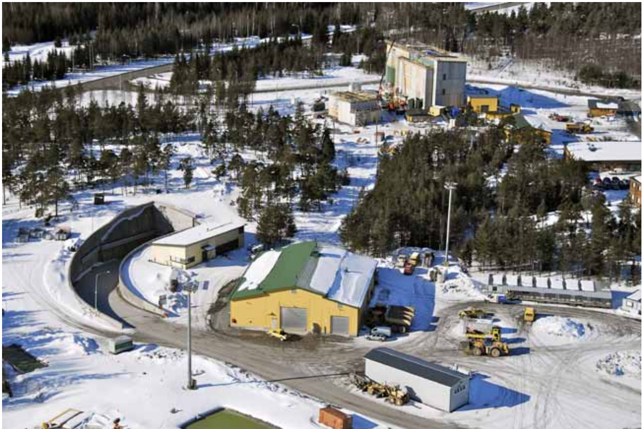
Ilmakuva talvelta 2011 Onkalo-työmaalta. Kuva: Posiva.
