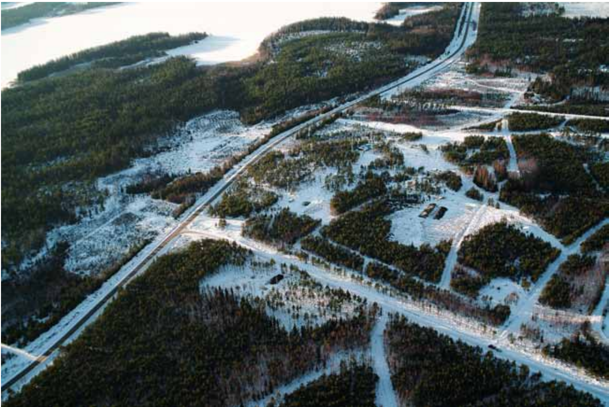
Ilmakuva talvelta 2004 Onkalo-työmaalta. Kuva: Posiva.
