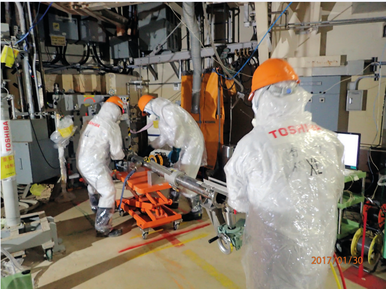
Kuva 1. Toshibaa työntekijöitä kakkosyksikön reaktorirakennuksessa työntämässä kameraa suojarakennukseen seinän läpivientiputken kautta (kuva: TEPCO).
