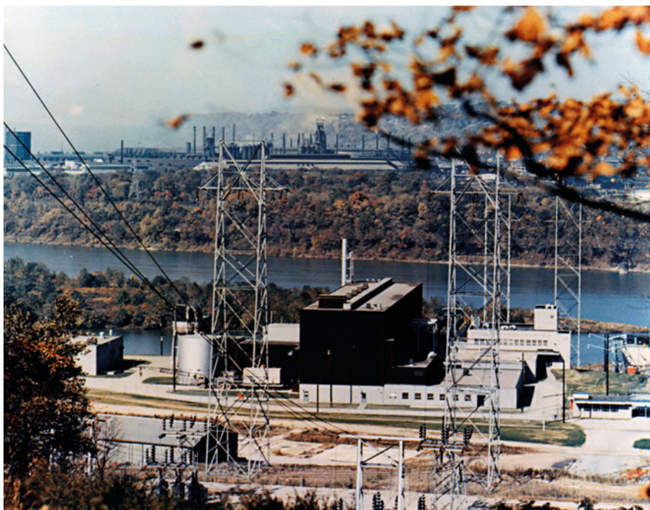
Shippingportin painevesilaitos oli USA:n ensimmäinen kaupallinen ydinvoimala, joka aloitti toimintansa 1957. Reaktori toimi 1970-luvulla myös toriumpolttoaineella (kuva: DOE).
