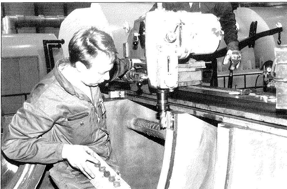
Pinnoituksen jälkeistä koneistusta Loviisa 2:n nelosturbiininin korkeapainepesässä kesällä 1990.
