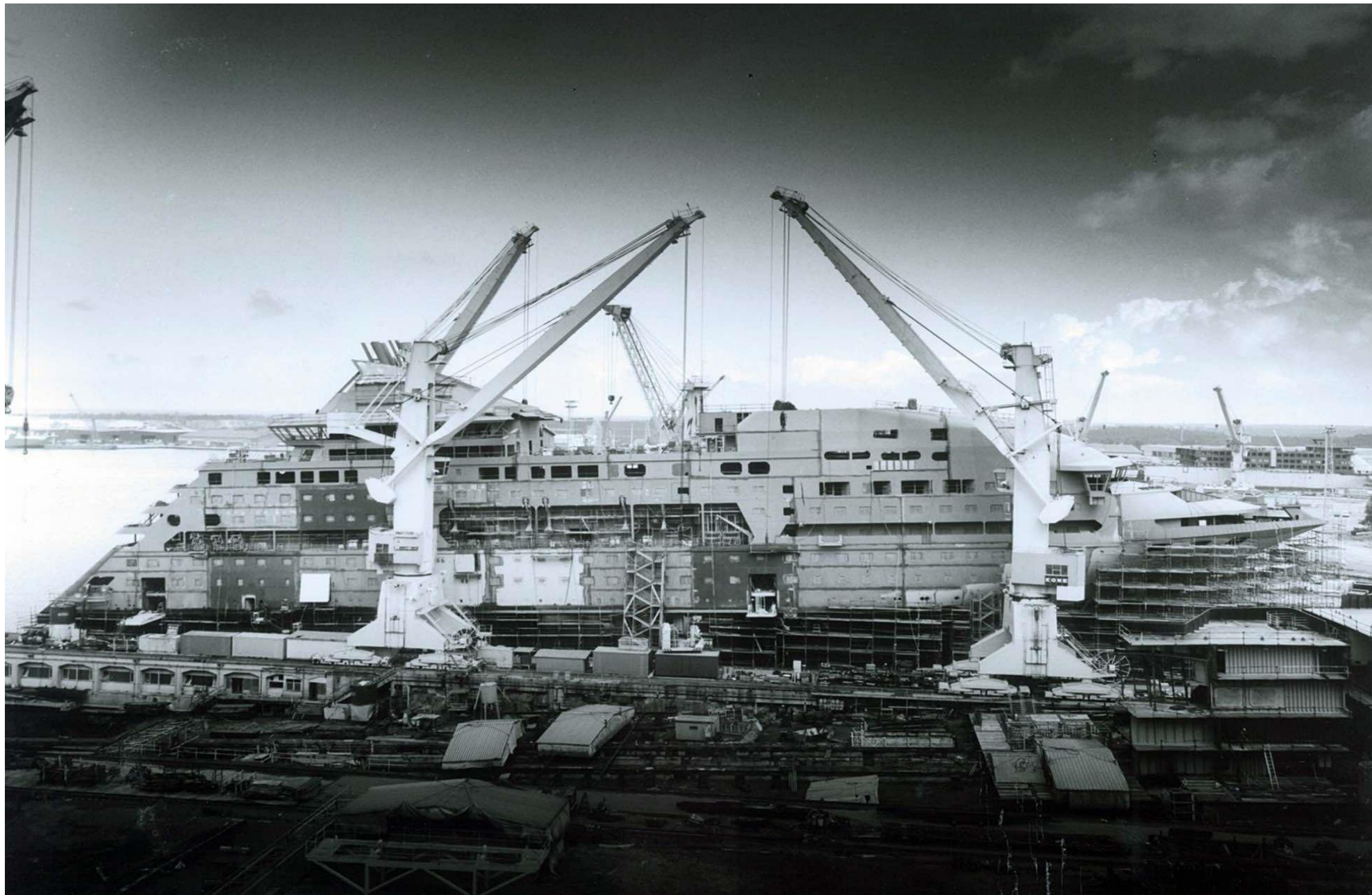
Runko Rauma Yards Oy:n slipillä, rak.no 309 eteläisellä telakalla 1991
