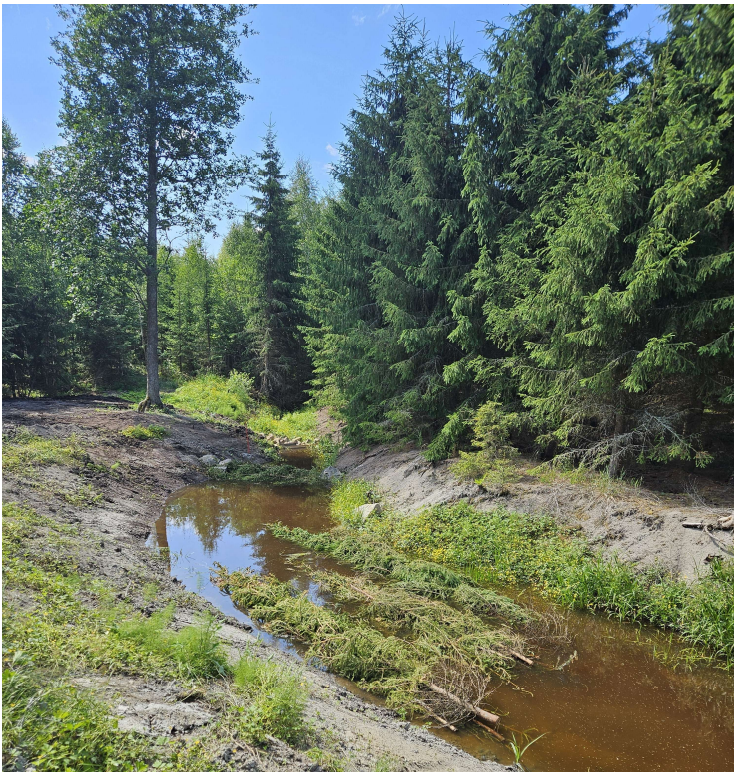
Kuva 1: Kortteenpohjassa Aito Suvi ry:n aiemmin kaivamaan laskeutusaltaaseen nostettiin talkoolaisten sitomia, 4–6-metrisiä uppopuunippuja. Nippuja on alussa ja lopussa poikittain ja keskellä pisimmän altaan myötäisesti.
