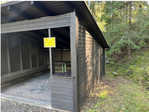
Laavu valmiina ja maalattuna
