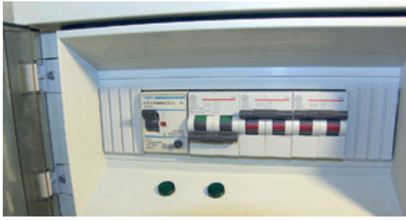
3.7. Tyypillinen veneen maasähkökeskus.
