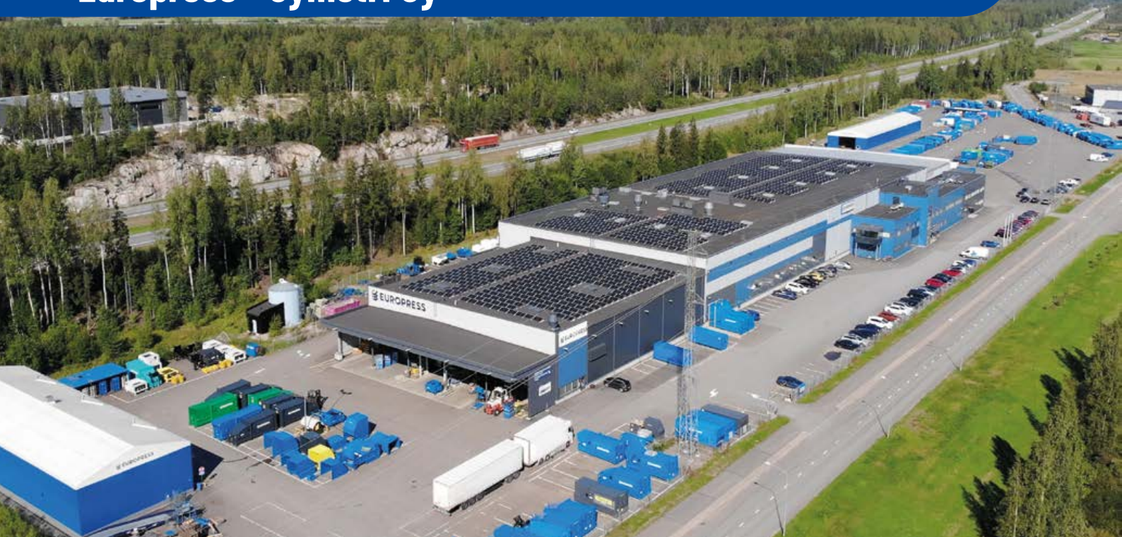
Ilmakuva Europress-tehtaan katolla olevista aurinkopaneeleista.
