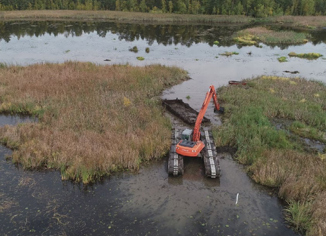
Ruoppaaja kaivamassa Saarioisjärvelle avovesikana- vaa syyskuussa 2019. Kuva: PK productions.
