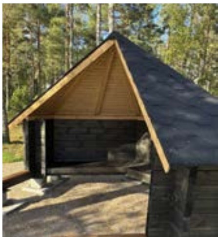
Uimarannan laavu on pystytetty.
