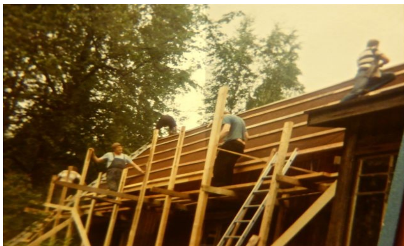
Huopakaton päälle tehtiin talkoilla peltikatto
