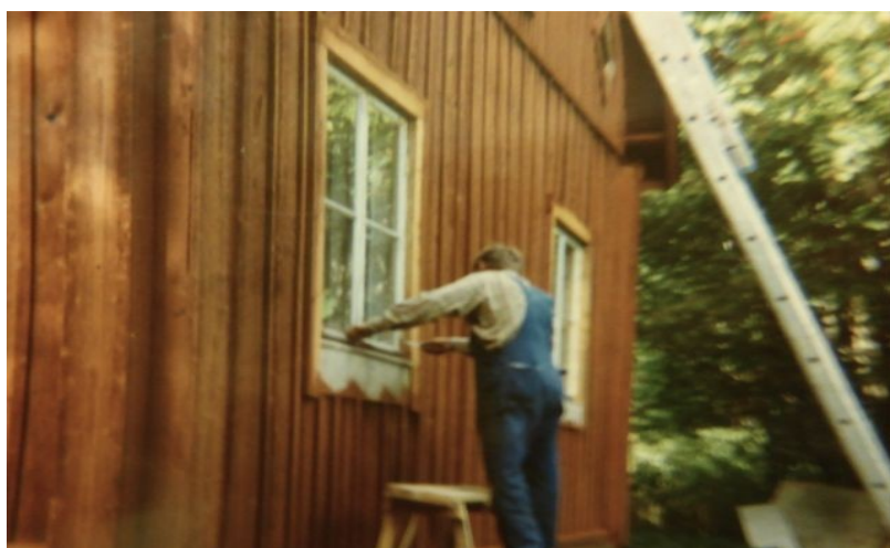
Vanhat huonokuntoiset kuusiruutuiset ikkunat vaihdettiin vanhainkodin neliruutuisiin
