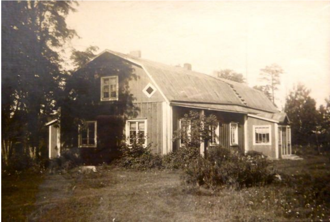
Syrjän päärakennus 1930-luvulla (Risto Huhdan kuva)
