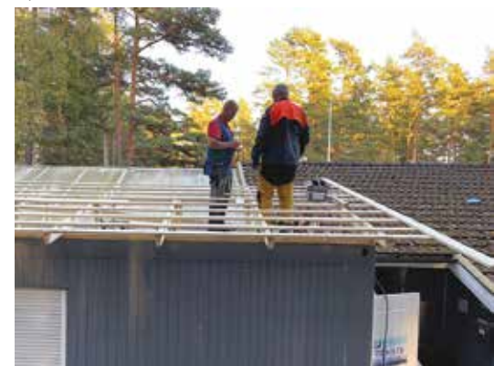
Yhdistyksen toimiston katto tehtiin uusiksi ennen talven tuloa.
