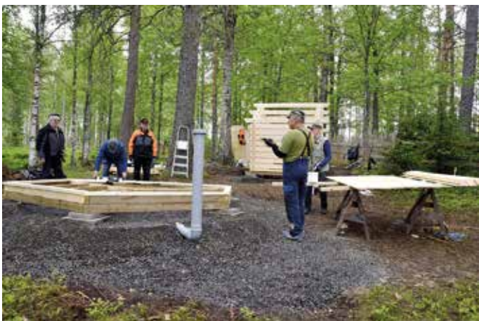
Perustukset valmiina. Työ jatkuu. Kuva Ismo Laine.
