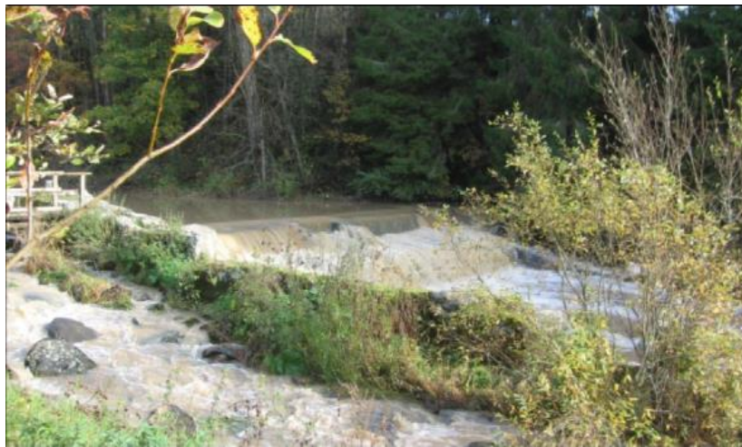
Koski tänä päivänä kalaportaineen. Keskellä patoa on luukku, jolla veden koreutta yläpuolisessa vesistöissä voidaan säädellä.
