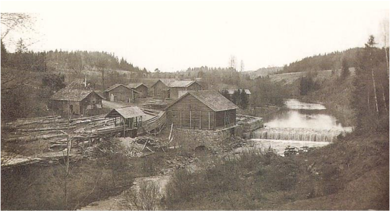
Kuva on vuodelta 1909. Mylly on kiviperustalla ja saha ulkona katoksessa. Taaemmassa rakennuksessa asui myllärin perhe. Näyttää elinvoimaiselta paikalta, vaikka nyt hiliainen.
