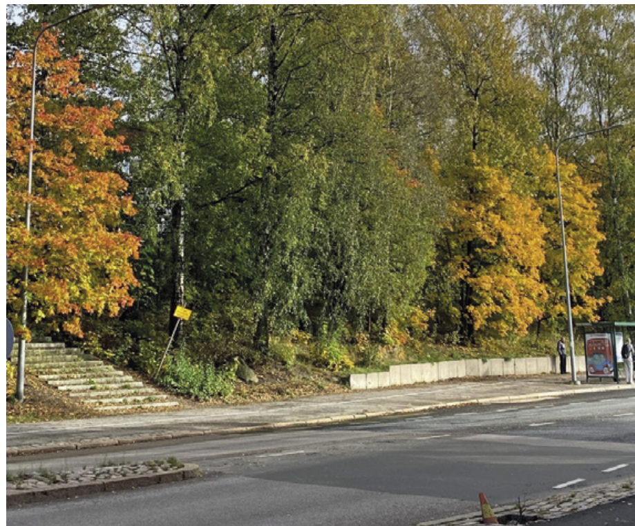
Pakila-Paloheinä -alueelle on suunniteltu kolmea rakentamisen aikana raskaalle ajoneuvoliikenteelle tarkoitettua kuilua ja ajotunnelia. Näistä yksi sijaitsee kuvassa näkyvien Pakilantieltä Suursuonpuistoon johtavien portaiden läheisyydessä. Muita kuiluja ja ajotunneleita on suunniteltu Kehä I:n ja Pakilantieltä sille johtavan rampin väliin jäävän huoltoaseman tontille sekä Kuusmiehentien pohjoispuolelle nykyisen Paloheinän golfkentän pysäköintialueen länsipuolelle.
