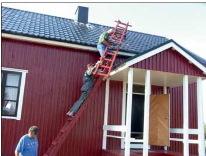
Käynnissä palotikkaiden asennus.
