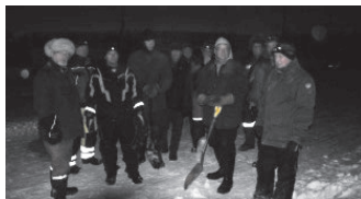
Kuva: Porokisojen rakentajia pakkasillassa
