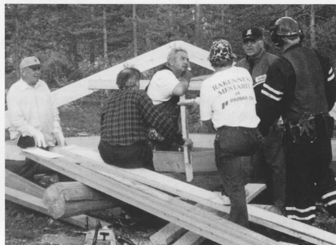
Katontekovaihe torni-rakentamisessa. "Kyllä se tästä" näyttää veli Juhani tuumaavan.
