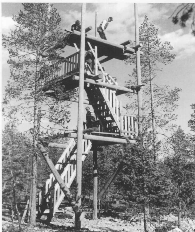
Ylöspäin ollaan menossa jo kolmannella tasanteella.
